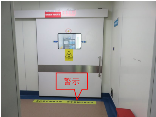
图 3-3 病人出入机房防护门
