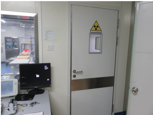
图 3-2 控制室出入机房防护门
