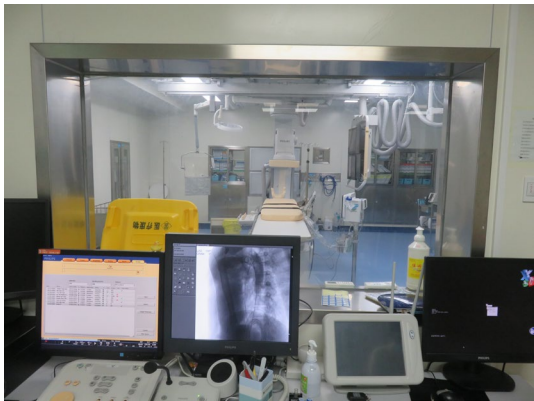
图 3-1 控制室铅玻璃观察窗
