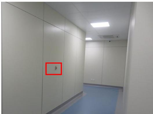
图 3-15 机房迷道墙面急停按钮
