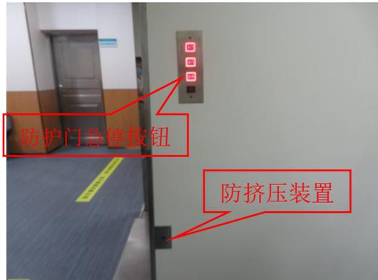
图 3-14 机房防护门急停按钮及防挤压装置
