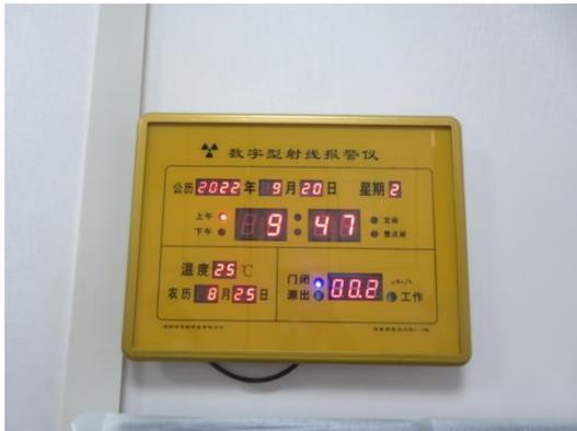
图 3-29 在线辐射监测仪控制室显示单元
